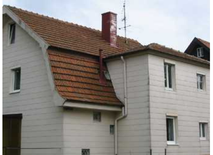
Asbesthaltige Fassadenverkleidung
