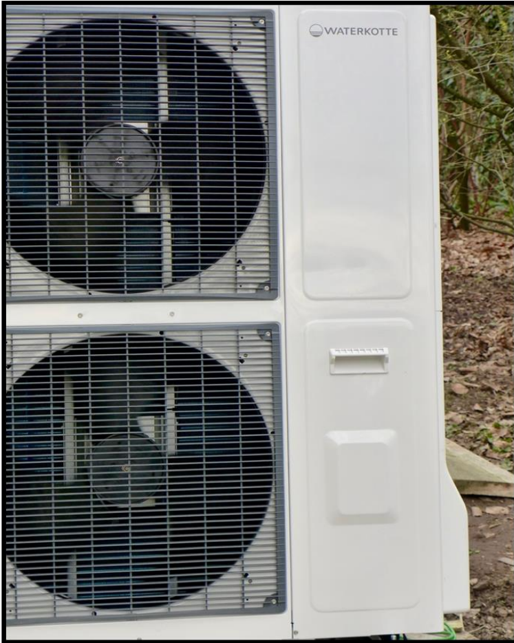
Außeneinheit mit zwei Lüftern, Ansicht o. Lärmschutzhaube
