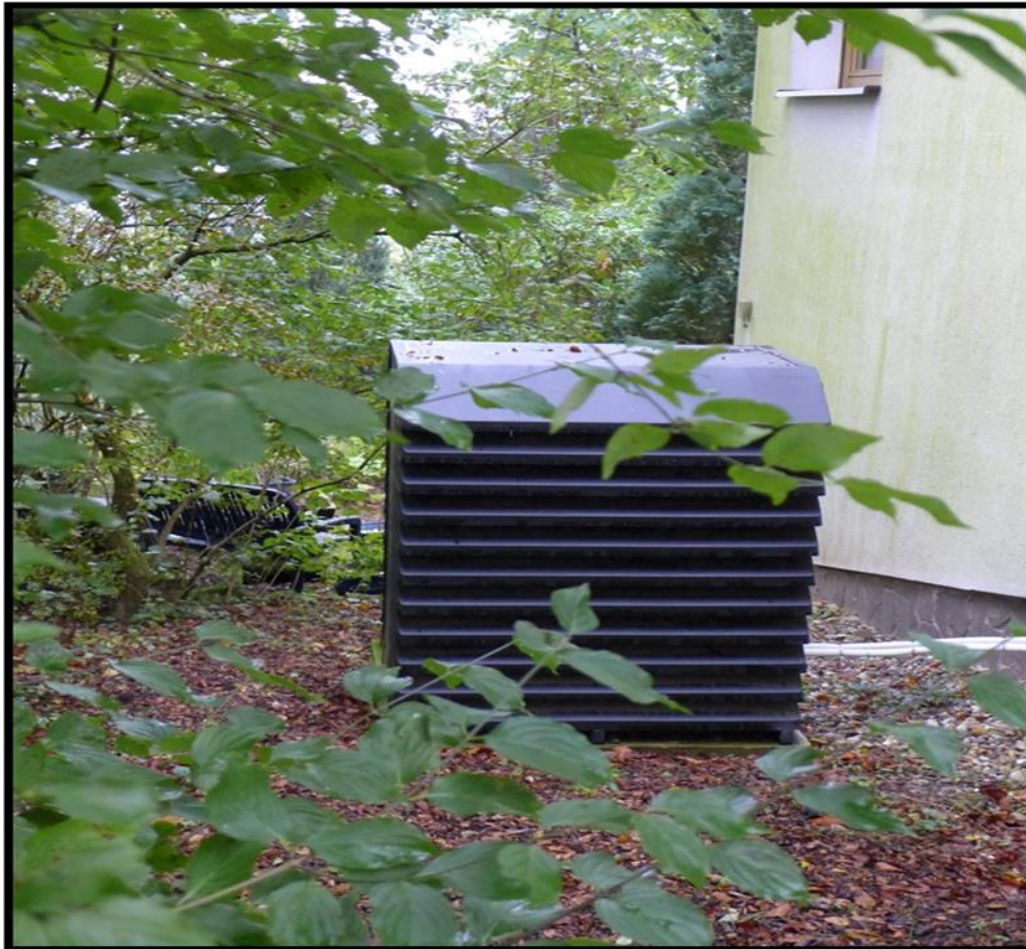
Außeneinheit mit Lärm- und Wetterschutz
