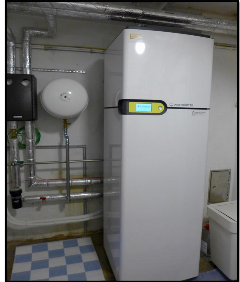
Inneneinheit mit integriertem Warmwasserspeicher
